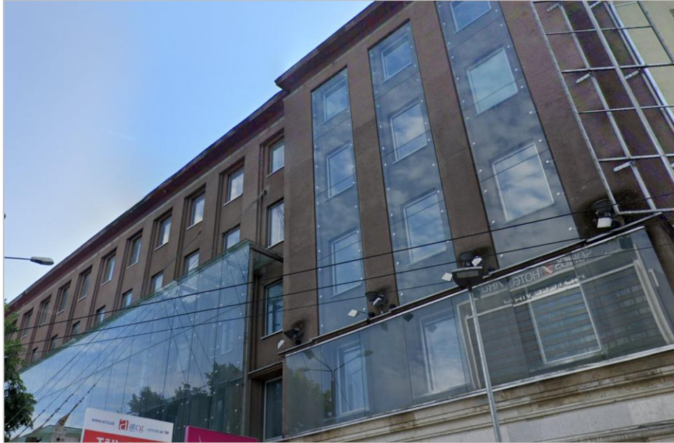
Joonis 3. Klaasitud topelfassaad ning lisaklaas avatäidete ees. Allikas: Google Maps, Estonia pst 1, Tallinn
